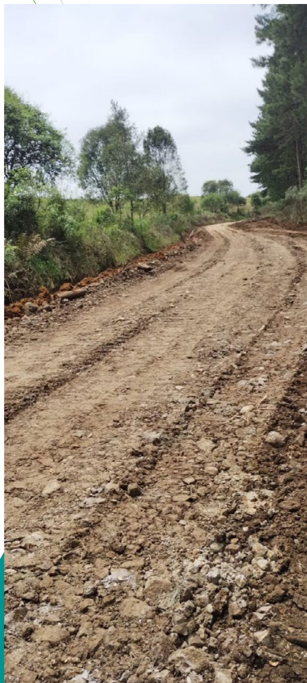
Melhorias estradas da Fazenda Sincol
