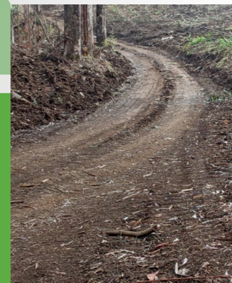
Manutenção de estradas-Sincol
