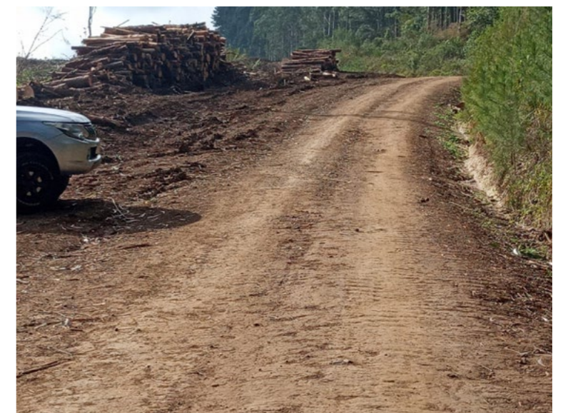
Manutenção de estradas-Horizonte I
